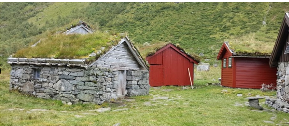
Figur 23: Bruk av lokalt tilgjengelige materialer på Instestøylen. Bygg av naturstein, tømmer og torvtak.
