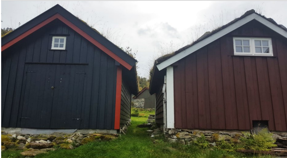
Figur 1: Bygg 1 til venstre og bygg 2 til høyre.
