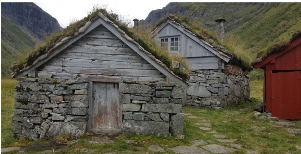
Figur 8: Knutebruket på Instestøylene, de to eldste byggene på stølen. Selet til Knutebruket, bygg 13 foran og fjøset bygg 12 bak.
