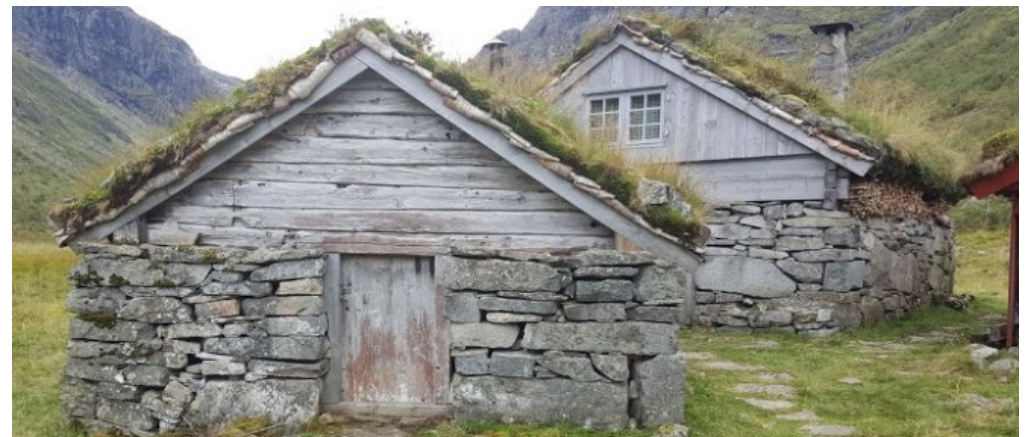
Figur 72: Man kan ikke se at fjøset i bakgrunnen på Knutebruket har blitt innredet med moderne fasiliteter.
