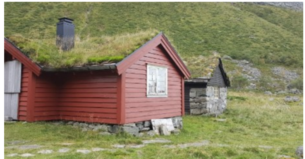
Figur 2: Bygg 2 med rødt liggende vestlandspanel og tilbygg på langsiden.
