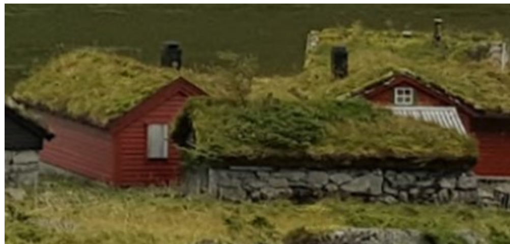
Figur 6: Bygg 10 med einer og bjørk på taket og torvtak som har siget ned såpass at eternittplatene synes. Foto: AGH.
