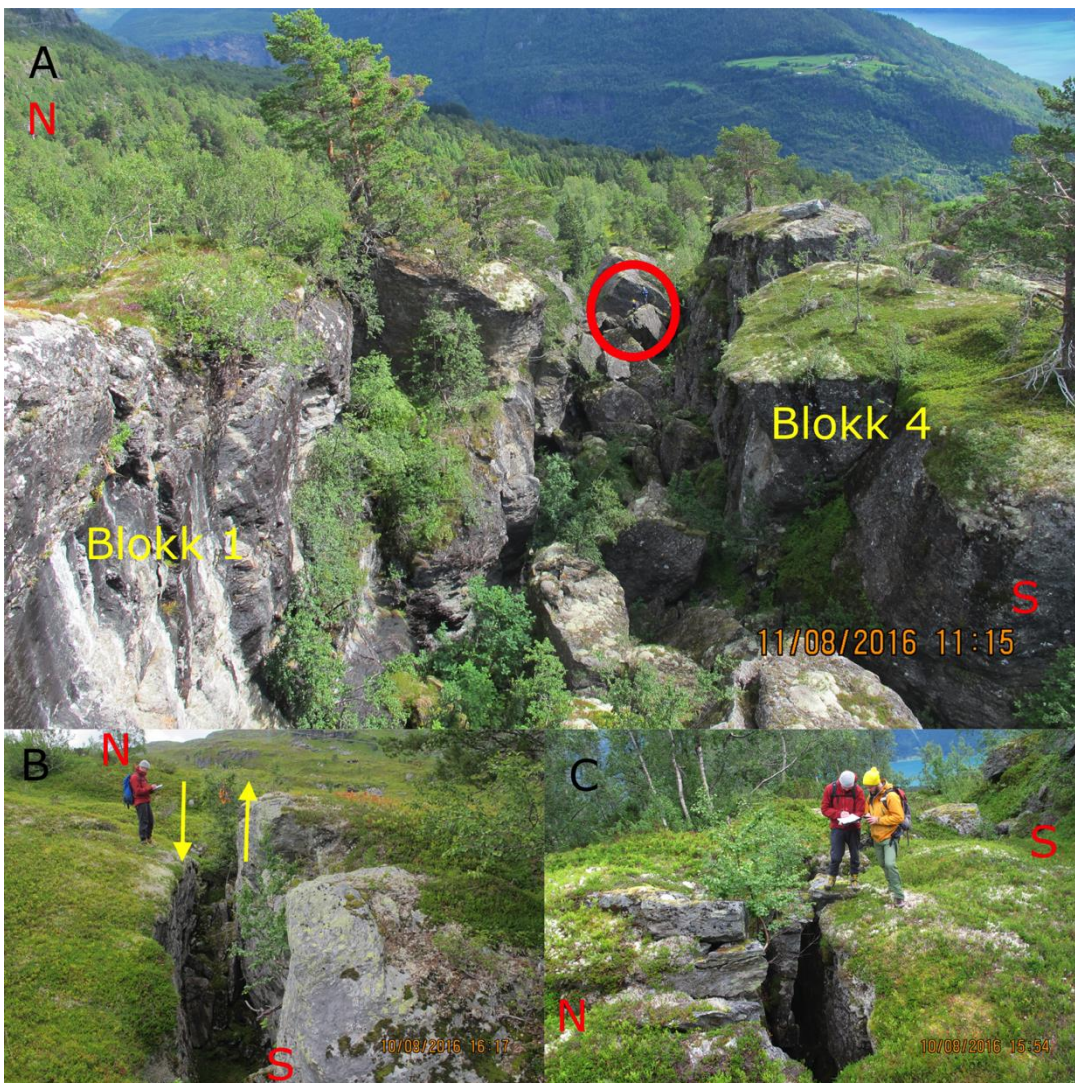
Figur 24 A er en spalte i sprekkesett 1M, spalten er fylt med blokker av fyllitt. I sirkel i A er to personer målestokk. Blokk 1 og 4 fra Figur 25. B er en del av sprekkesett 1M, piler indikerer vertikal bevegelse mellom to blokker. C er en del av sprekkesett 2M.
