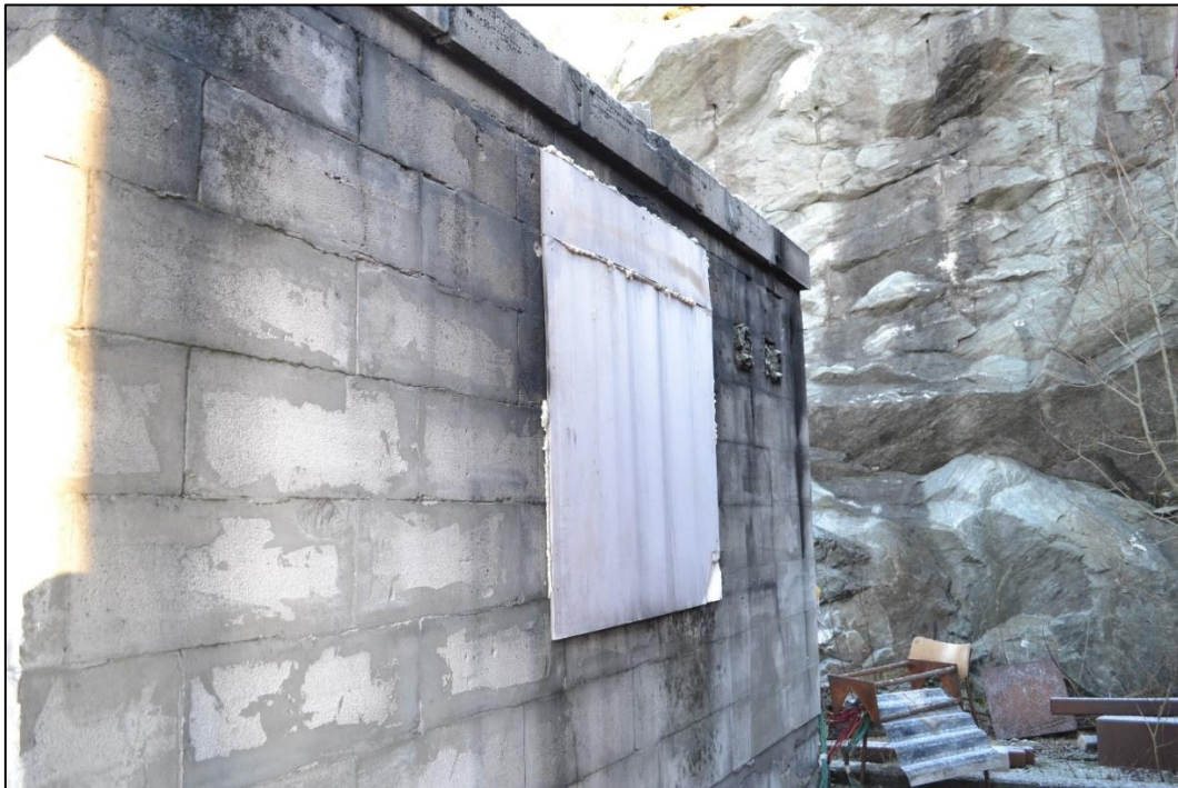
Bilde 4 - Plating av vindu som ikke er i bruk, med tilhørende innvendig isolering
