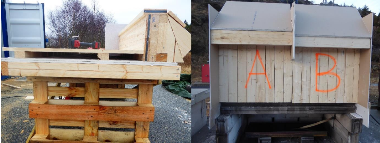
Bilde 5.2 Test 2 – Testrigg. Venstre: Kledning og takfot montert på gipskledd ramme, sett fra siden, før montering av gips på ytersiden. Høyre: Testoppsett 2 montert på toppen av brennkammer med gipsplater på yttersider og som tak.
