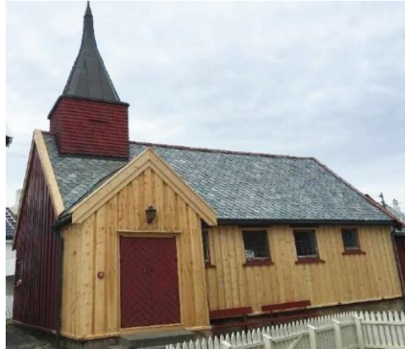
Bilde 1.1 Grip stavkirke etter brannskallsikring. Gjengitt med tillatelse. Kilde: [6]
