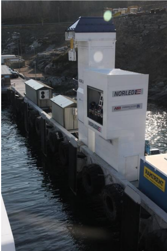
Figur 4-14: De to ulike ladeteknologien som blir anvendt for lading av ampere
