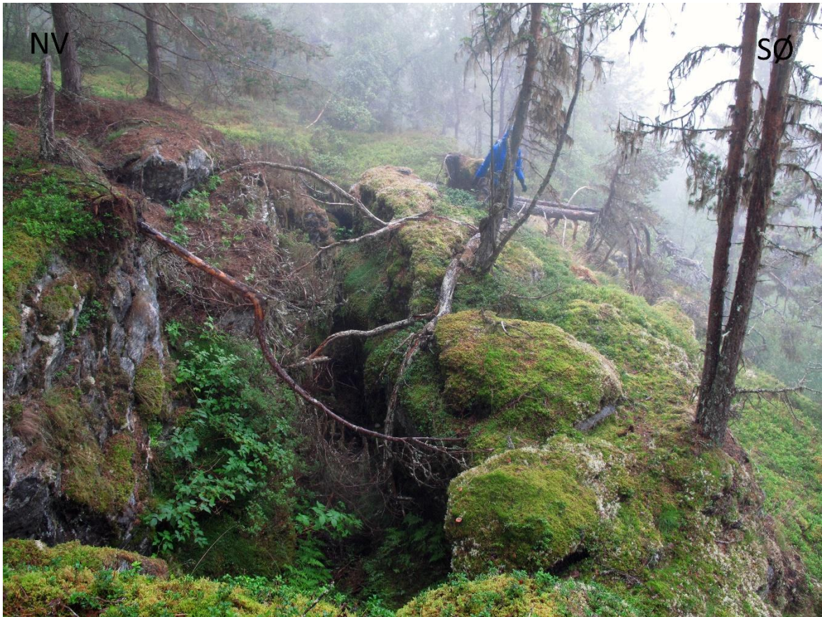
Figur 50: Oppsprekking i område 5.
