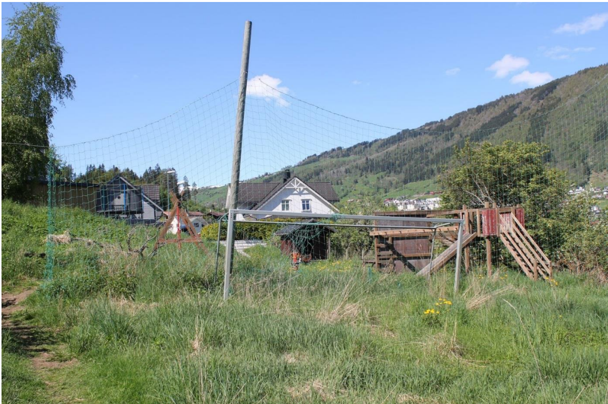
Figur 6: Lekeplass Stedjeåsen vest er et godt eksempel på en lekeplass med manglende vedlikehold.
