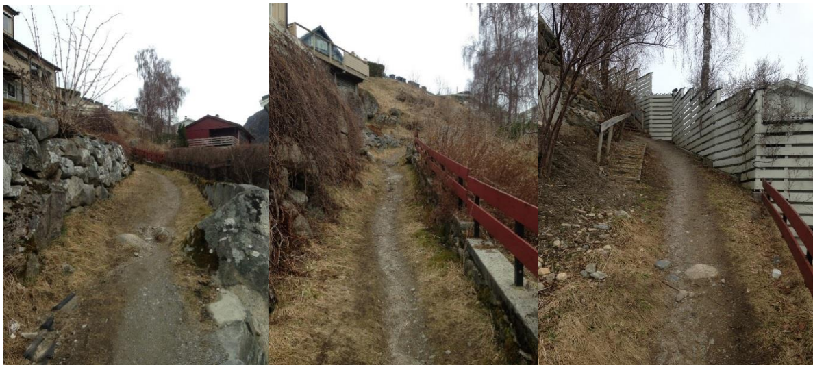
Figur 46: Navarsete 2 nord mangler belysning og ett godt rekkverk å holde seg i.
