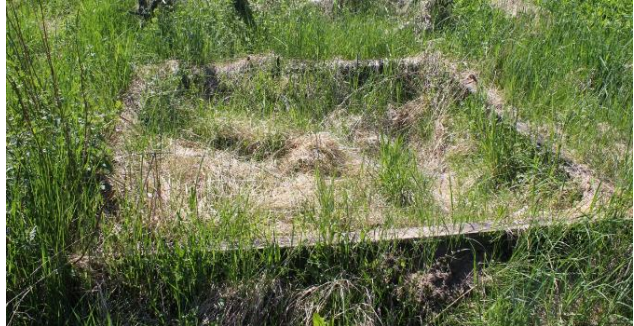
Figur 30: Sandkassen er helt gjengrodd og må restaureres.
