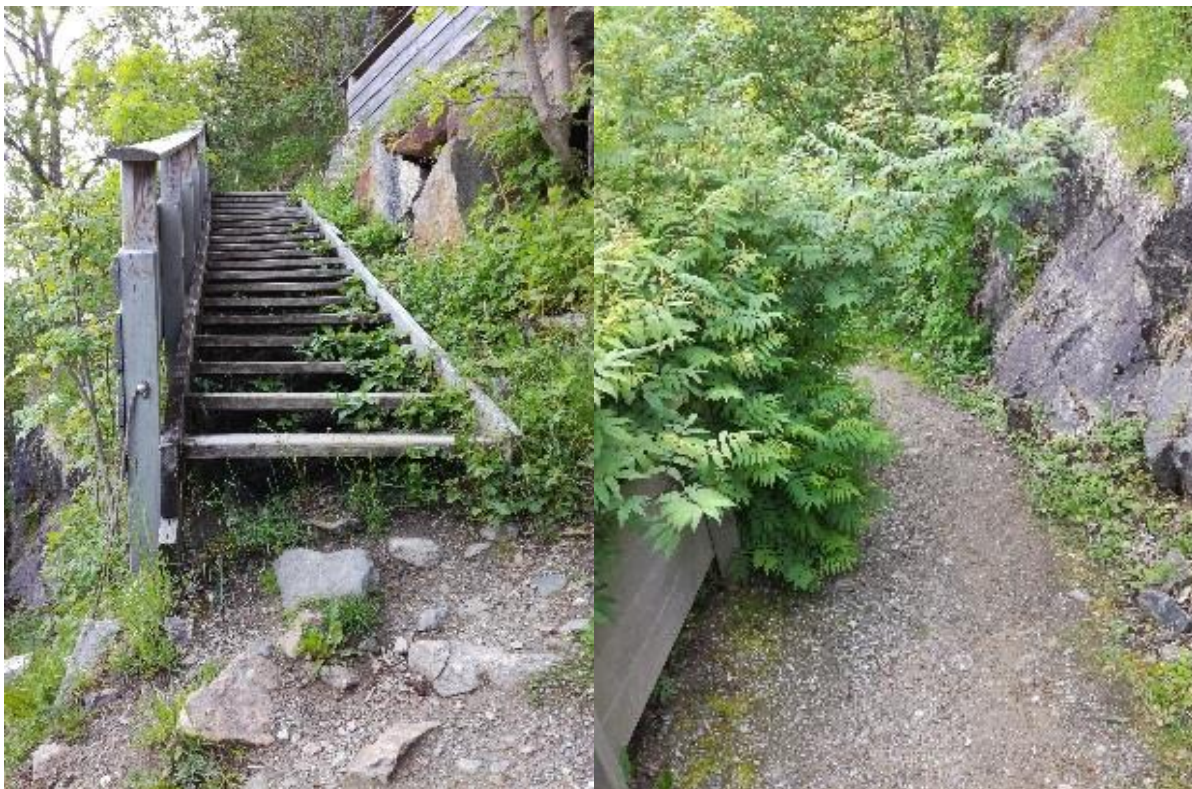
Figur 46: Det er stor høydeforskjell mellom trappen og bakken nederst i stien. Noen steder henger det også greiner ut i stien.
