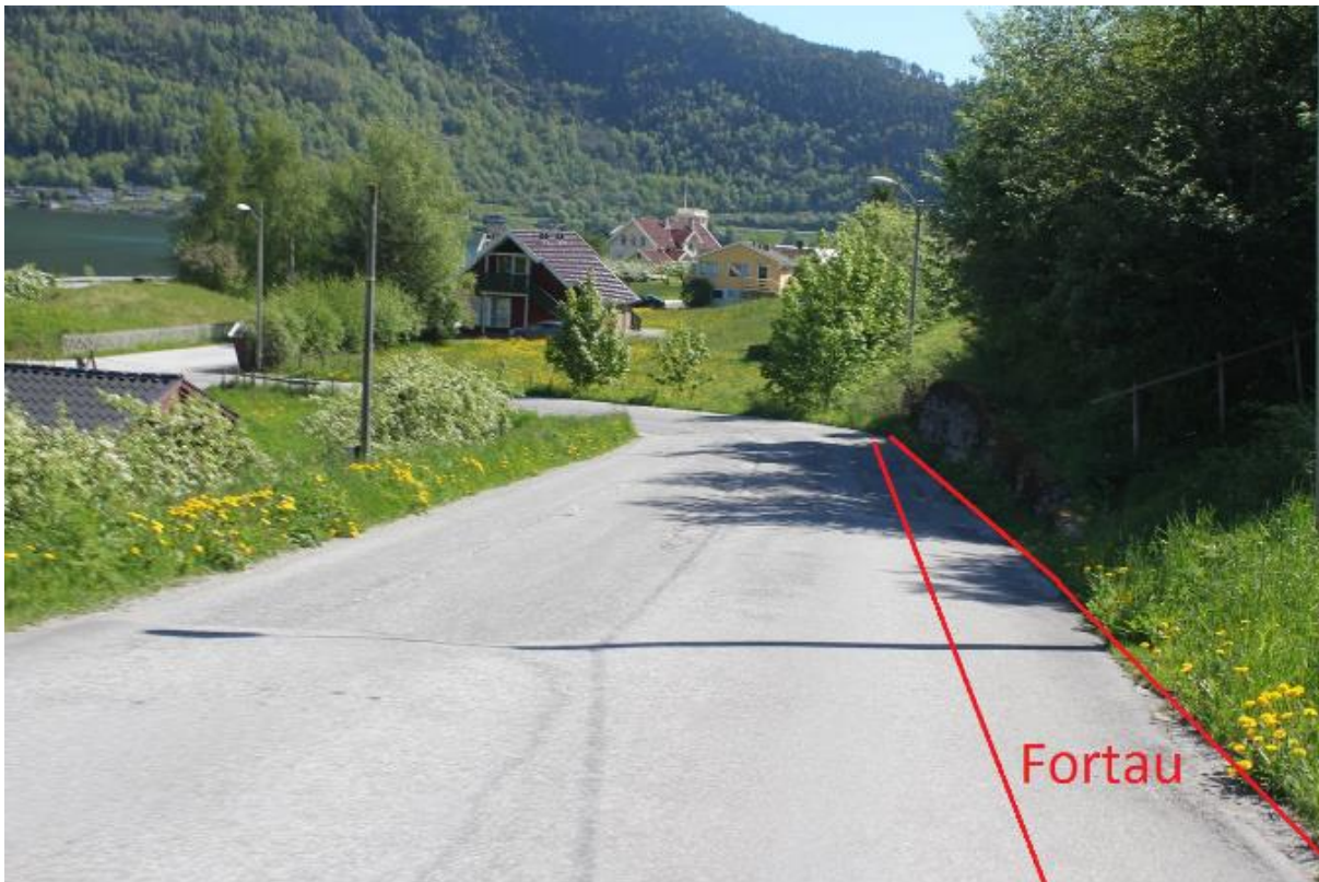
Figur 61: Her ser man veien øst for den uoversiktlige svingen, og hvor det foreslås å bygge fortau.
