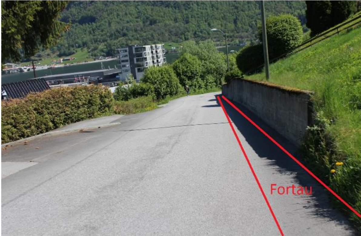
Figur 60: Bildet viser den uoversiktlige svingen i enden av det planlagte fortauet som skaper farlige situasjoner for gående.
