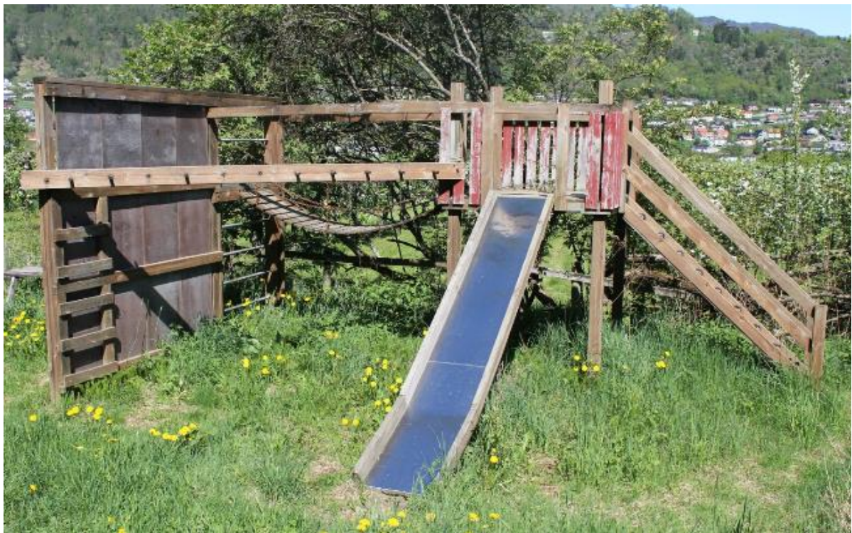
Figur 31: Klatrestativet er godt utformet, men i svært dårlig stand med rustne kjettinger og flisete treverk.
