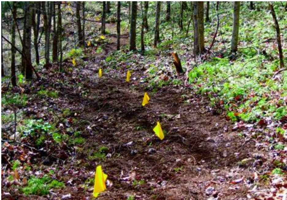
Figur 13: En ryddet korridor med flagg som markerer hvordan stien skal legges. (IMBA)
