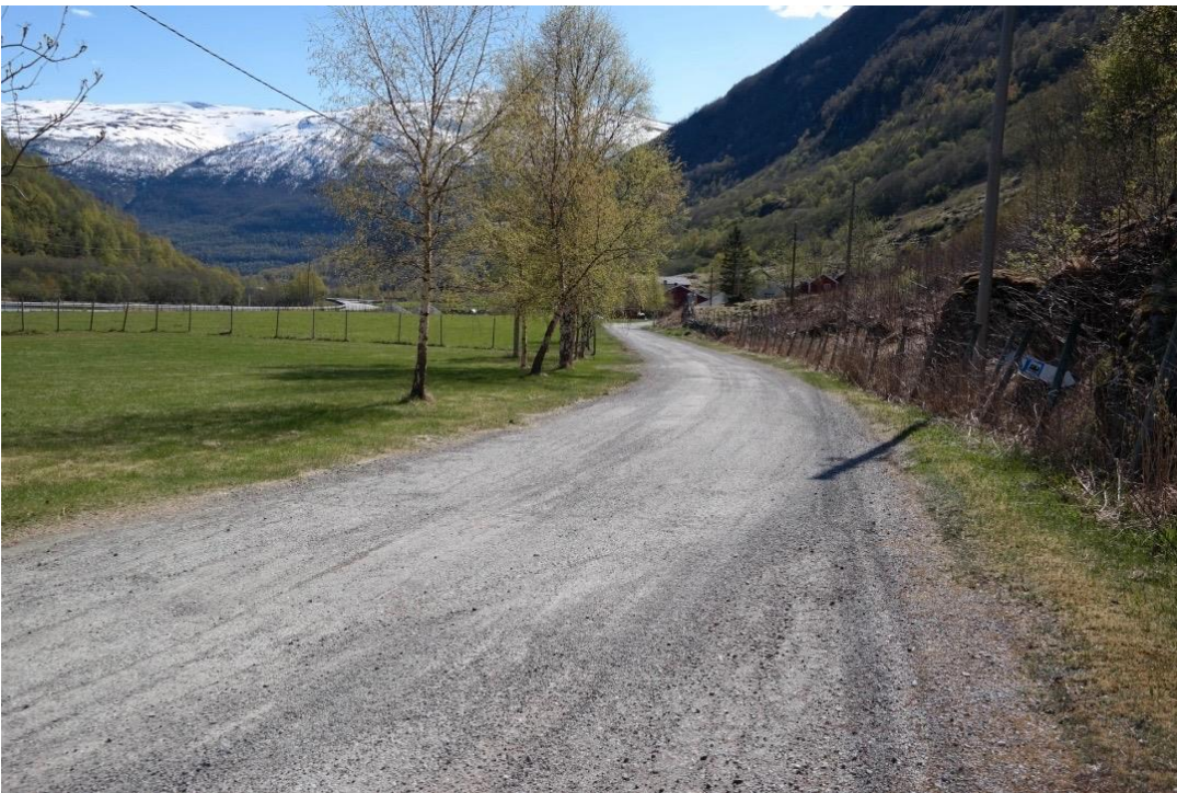
Figur 6: Borgund hyttesenter og camping. Bildet viser tilkomstveien som sykkelveien følger nedover. Her går sykkelveien frem mot utløpet til Borgundstunnelen.
