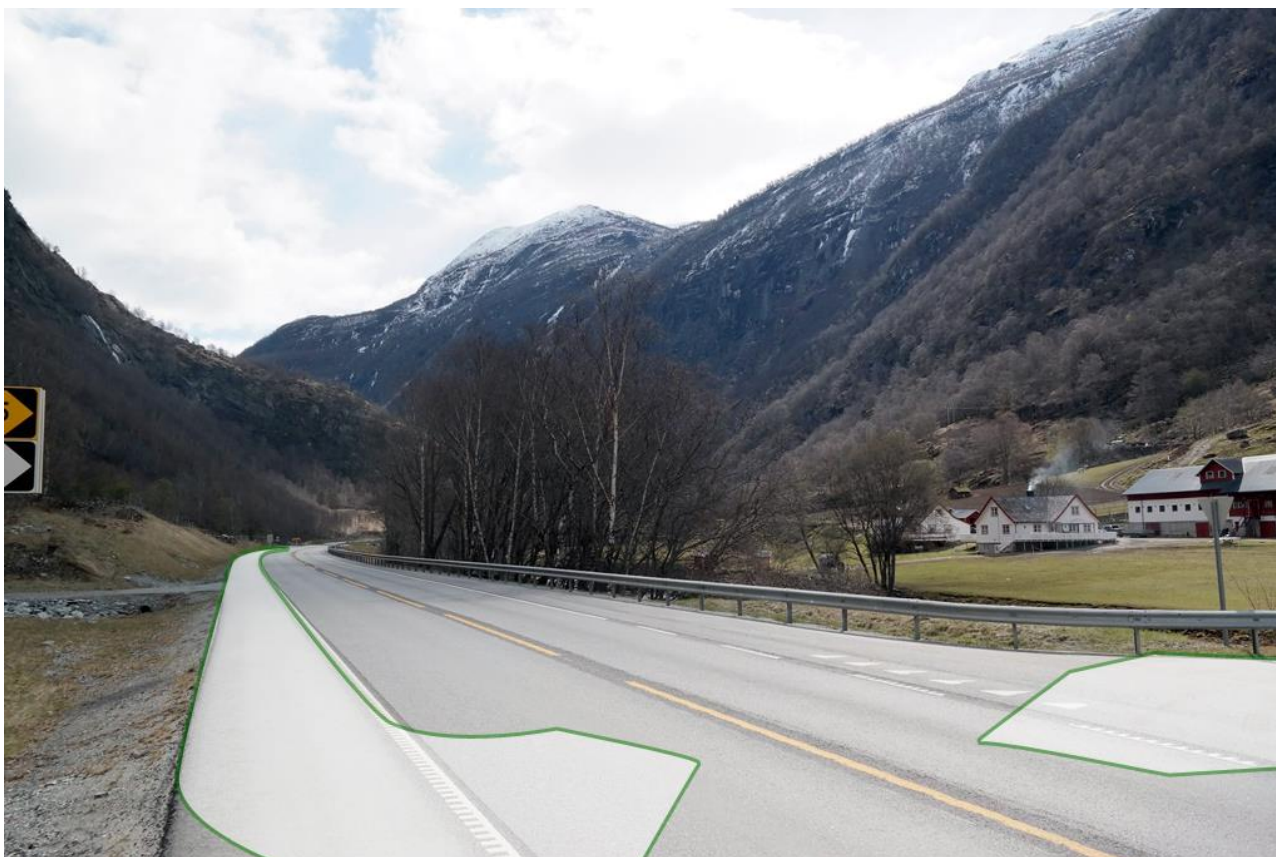
Figur 68: Visualiseringseffektene viser hvor den planlagte sykkelveien skal gå. Sykling foregår på nordsiden av E16 og krysningpunkt over til broen ved Søre Bjørkum.
