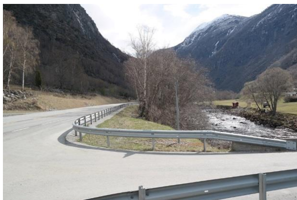
Figur 66: Ferdsel foregår på veiskulder frem mot avkjørsel og bro over til Søre Bjørkum. Bildet er tatt på broen, retning øst.
