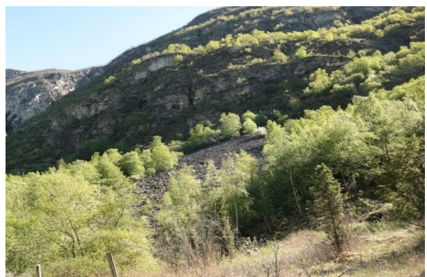
Figur 25: Bildet er tatt ved Færestad, Lærdal og viser skredmasser opp mot fjellveggene.
