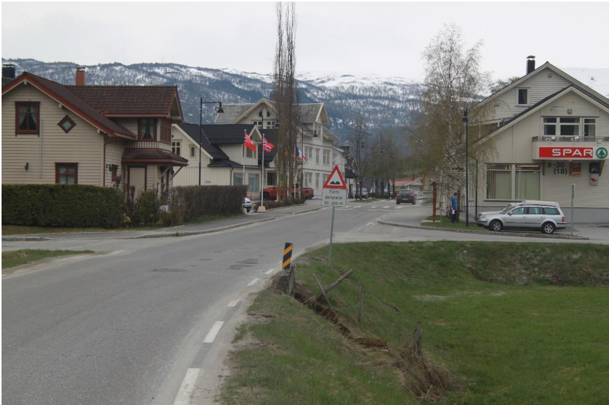
Figur 15: Bilde av innfallsporten til Hafslø sentrum fra østsiden, med Eikum Hotell til venstre og dagligvarebutikken Spar til høyre.
