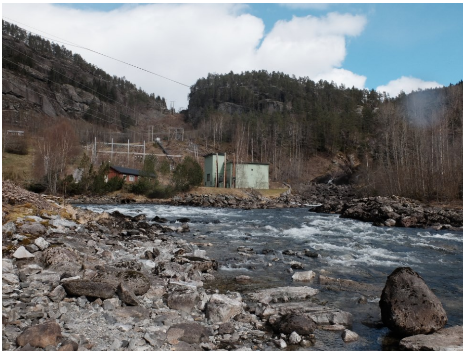
Figur 27: Utslipp fra Årøy ved Steig (venstre) og vann fra Årøy 1 slippes ut ved grønn bygning. Naturlig elveløp (høyre) er kraftig redusert. Foto: Martina Grøttå.
