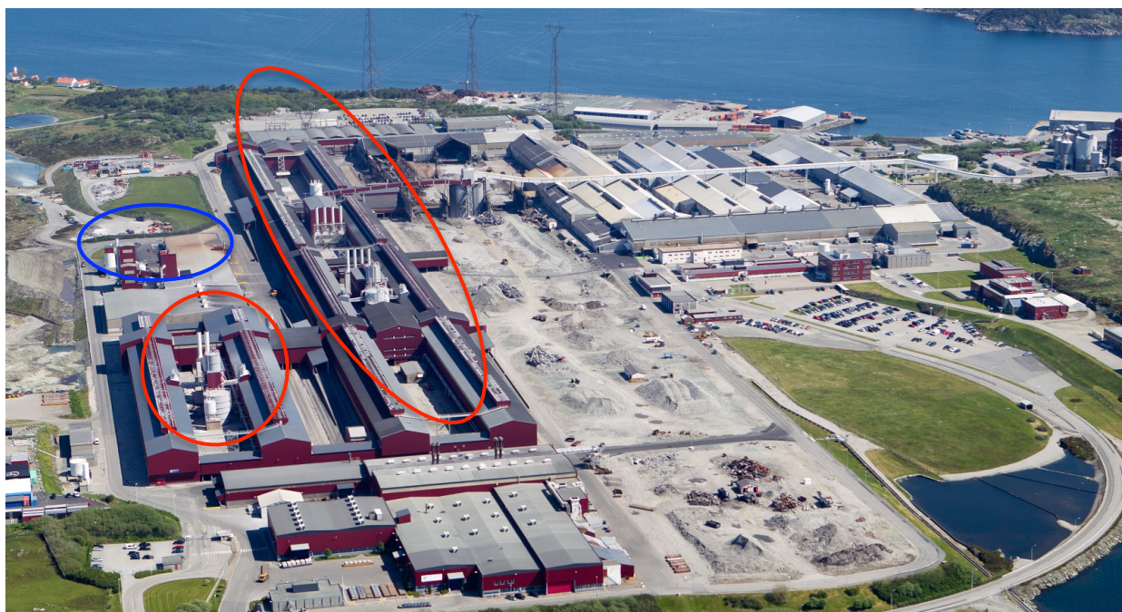
Bilde 2 Oversikt over Hydros anlegg på Karmøy. Anodemontasjen er markert med blått og Elektrolysen er markert med rødt. (Bilde brukt med tillatelse fra Hydro)
