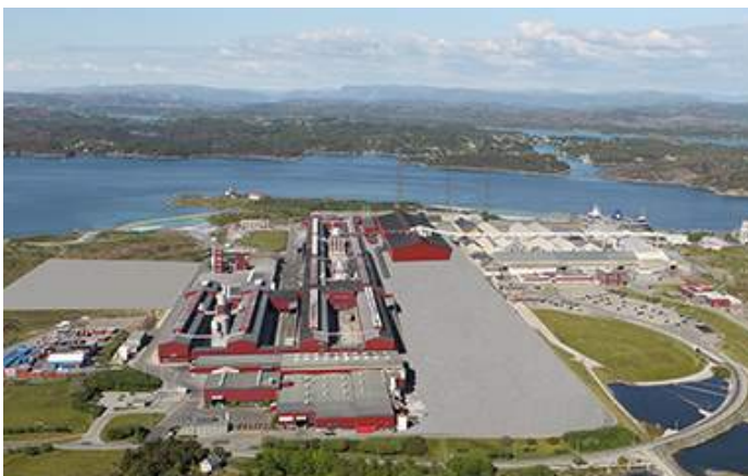
Bilde 1 Hydros fabrikk på Karmøy (Bilde brukt med tillatelse fra Hydro)
