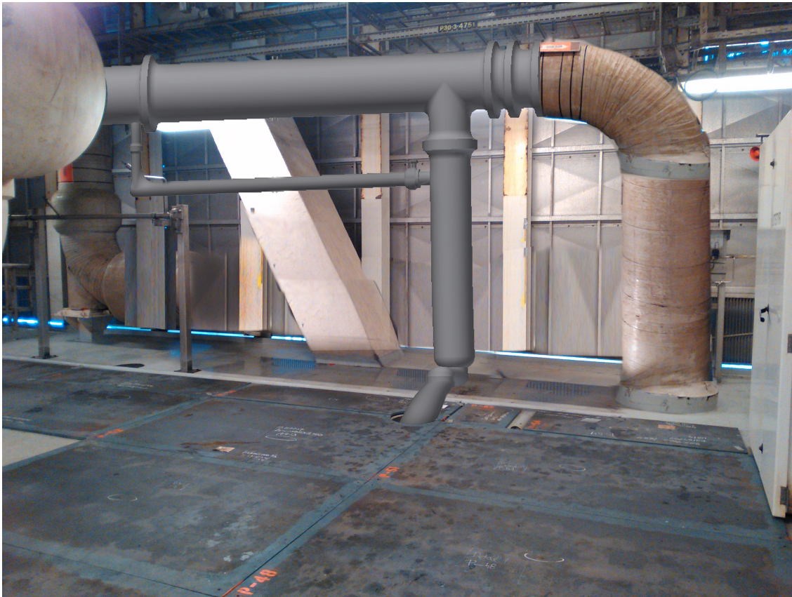
Figur 48 Visualisering av installert InLine DeLiquidizer. Foto, 3D-tegning og redigering av gruppen.
