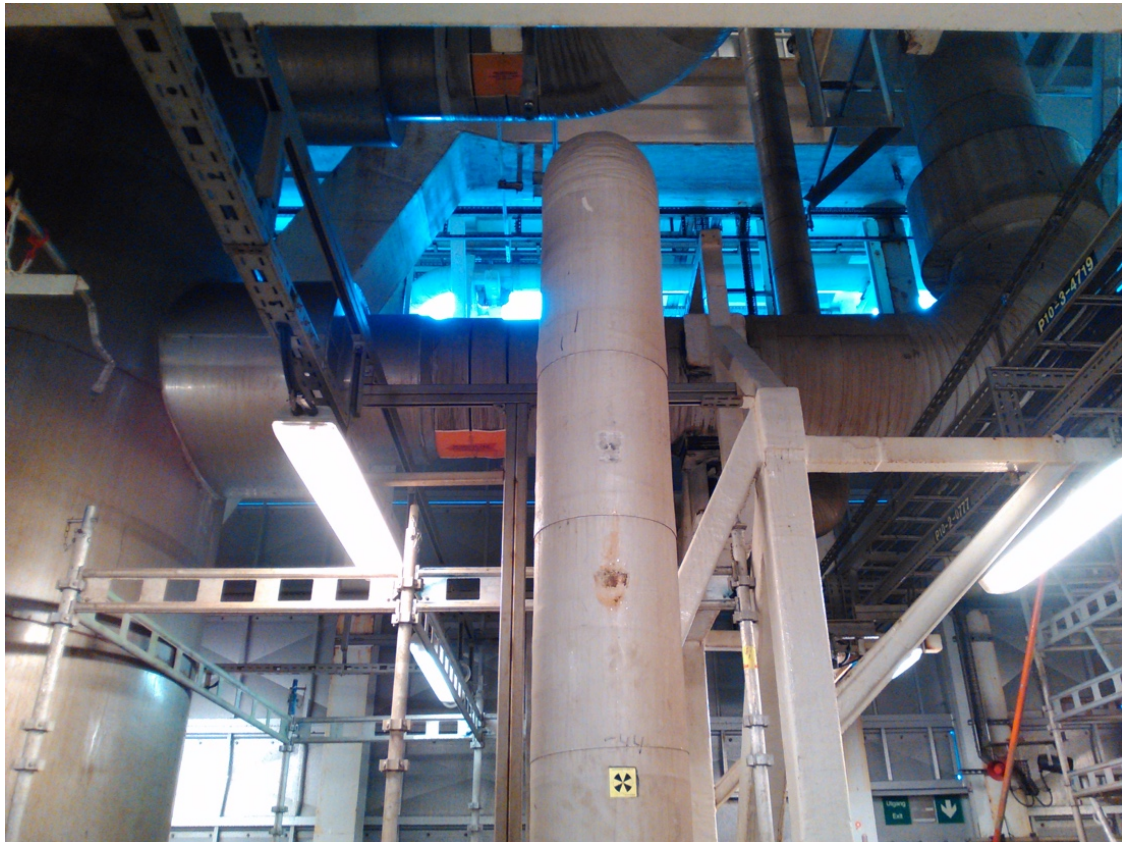
Figur 43 Tilgjengelig areal på sørsiden av væskeutskilleren. Foto av gruppen.
