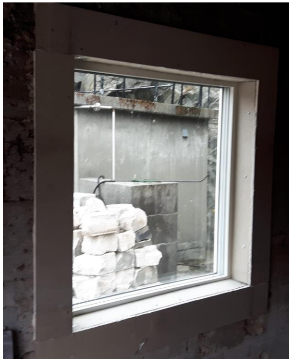
Bilde 7 - Gipskledning rundt karm
