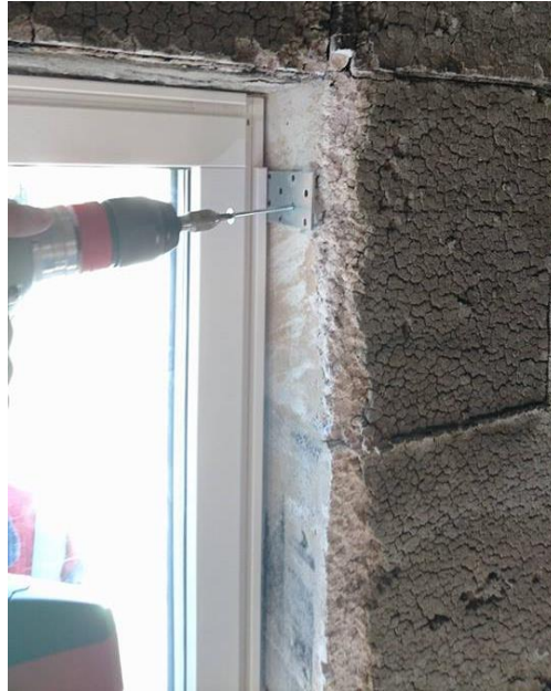
Bilde 4 - Forankring av vinduer
