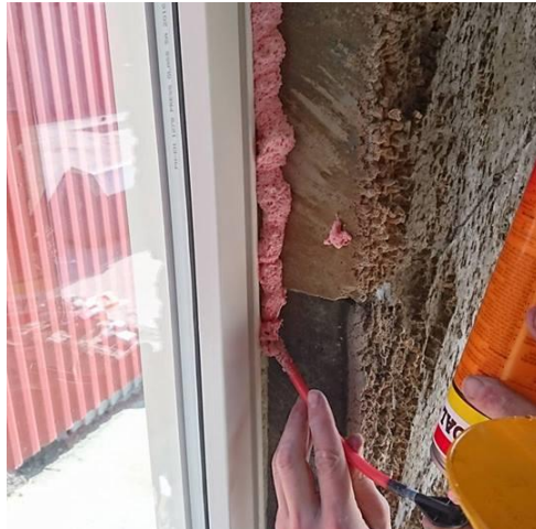
Bilde 6 - Påføring av ekspanderende brannskum
