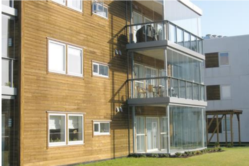
Bilde 1 - Brannspredning via innglasset balkong (26)
