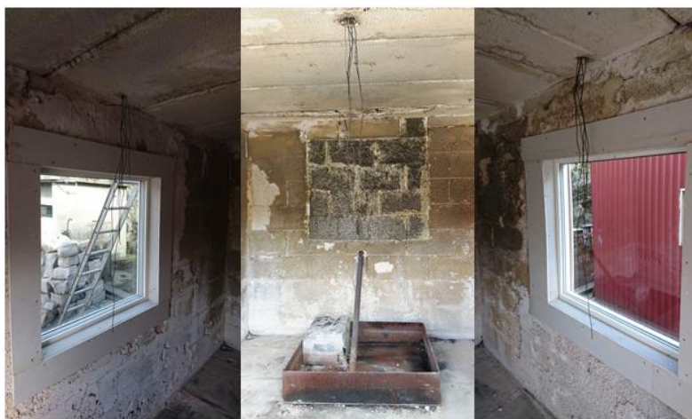
Bilde 10 - Plassering av termoelement
