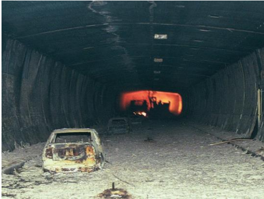
Figur 20: Bilde fra hvordan Tauerntunnelen så ut etter at slokkearbeidet i 1999 var avsluttet [95].
