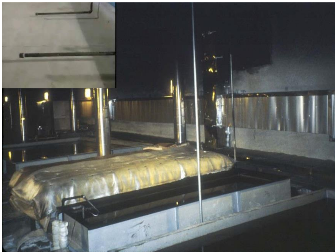
Figur 4.1: Det nærmeste til høyre er stålkår for 30 MW, etterfulgt av 10 MW, det tildekte for 20 MW og det bakerste for 50 MW [10]
