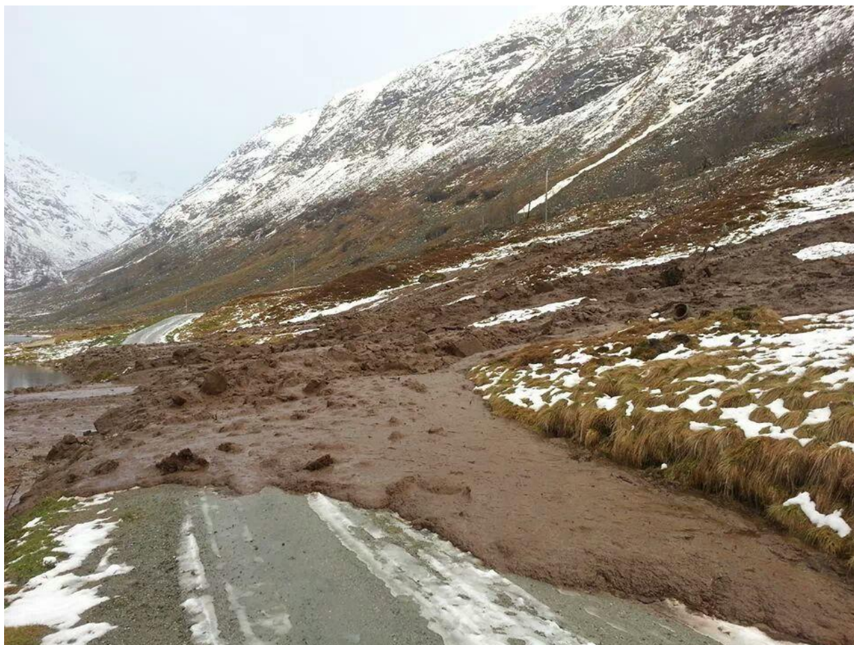
Bilde 5: Jordskredet sperrer veien inn til Anestølen. Bildet er tatt lørdag morgen den 16. november 2013. Selv om det har regnet kraftig og vært høye lufttemperaturer så er det fortsatt snø og is i veibanen. Fotograf: Vidar Leirdal
