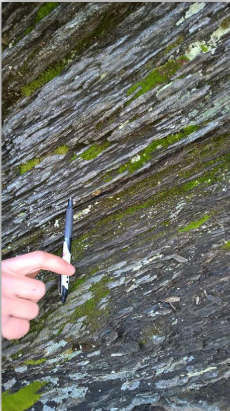
Figur 38: Bilde fra blotning 4, viser forvitret bergart i sone 3.
