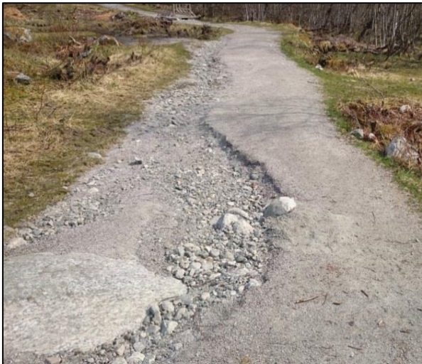
Figur 39. Veien har blitt vasket ut i bildet til venstre. I bildet til høyre er veien slik den vil se ut når den er fikset.
