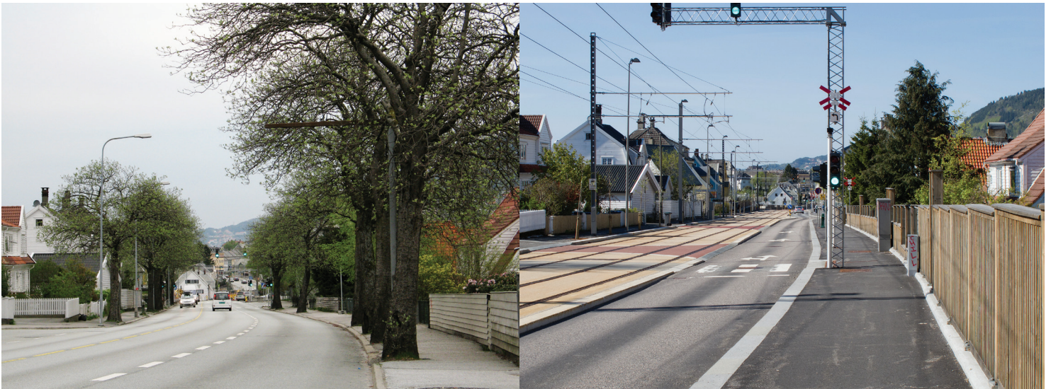
Figur 8 - Inndalsveien fra mai 2008 før utbygging og etter ferdigstilling i mai 2010
