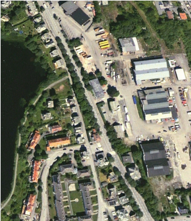
Figur 6 - Luftfoto 2005 Luftfoto: Google earth
