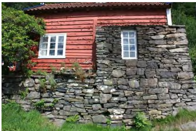
Fig. 24ab. Lokal byggeskikk fra Vestlandet. Eksempel på tørrmur for bolighus og hvordan bruk av steinmurer kan gi ekstra lagringsrom samt være et godt klimatiltak i boliger.
