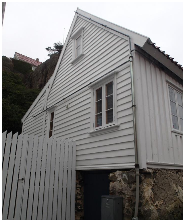
FIGUR 8 ET BYGG I GAMLE SKUDENESHAVN SOM HAR FASADESPRINKLER
