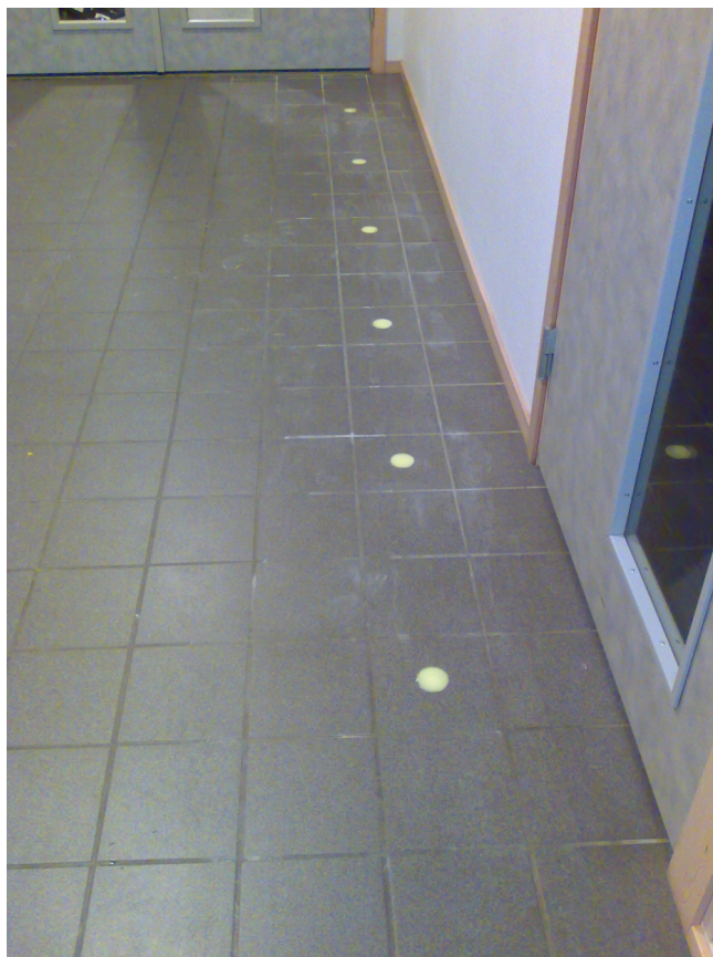
Figur 19 - Punktmarkering nedfelt i gulv. Foto: Drangsholt.
