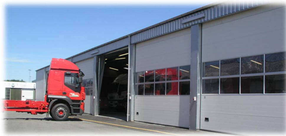
Figur 17 - Porter med vindu
