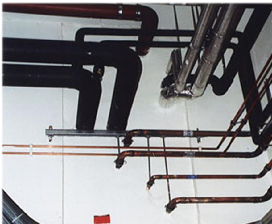
Figur 16 Riktig rørtetting med GPG (Olstad, 2013)
