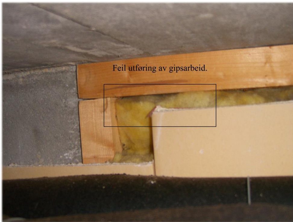
Figur 14 Feil i gipsarbeid (Olstad, 2013)
