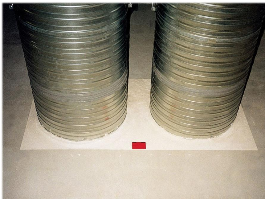
Figur 1 Riktig utført gjennomføring i brannklassifisert vegg (Olstad, 2013)
