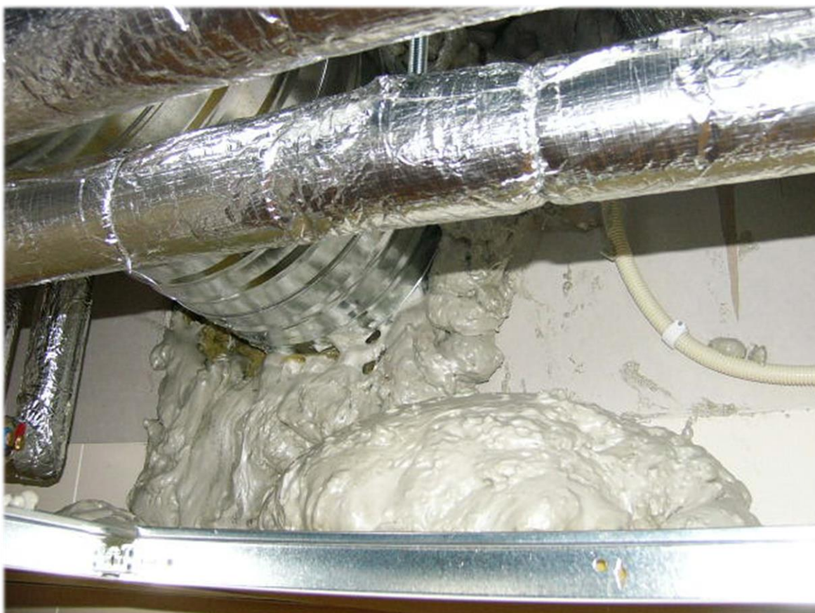
Figur 10 Tetting med byggsaum (Olstad, 2013)
