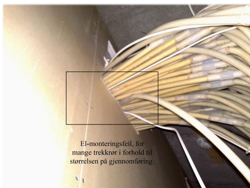
Figur 29 El-monteringsfeil (Olstad, 2013)
