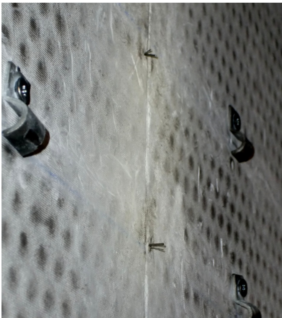
Figur 15: Plassering av termoelementer (senter). Deteksjonslinjene ble montert med slangeklemmer (sider) slik at de lå ovenfor termoelementene.
