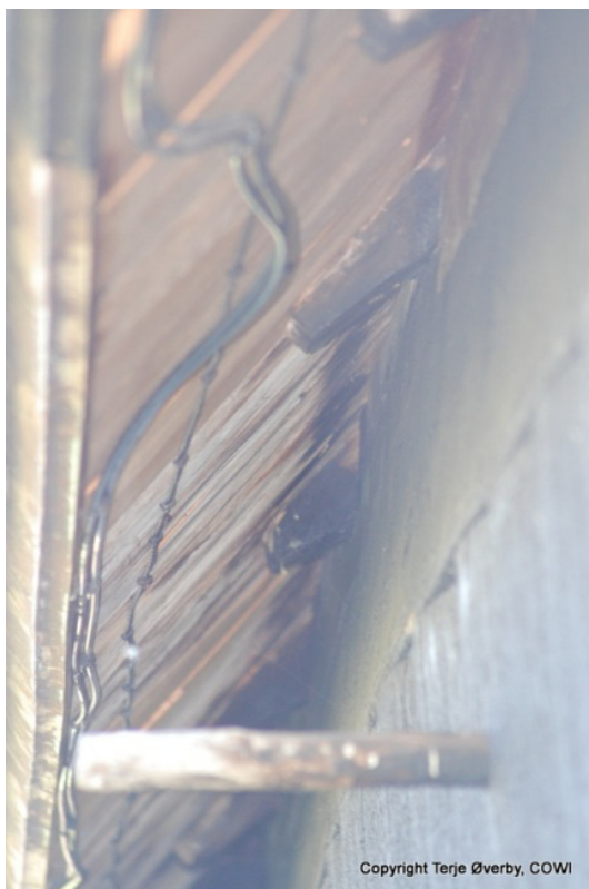
Figur 1: Plassering av deteksjonslinje under raft (Foto: Terje Øverby, COWI, 2011).
