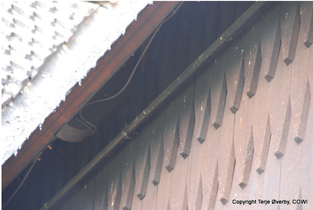
Figur 3: Montering av deteksjonslinje under raft (Foto: Terje Øverby, COWI, 2011).
