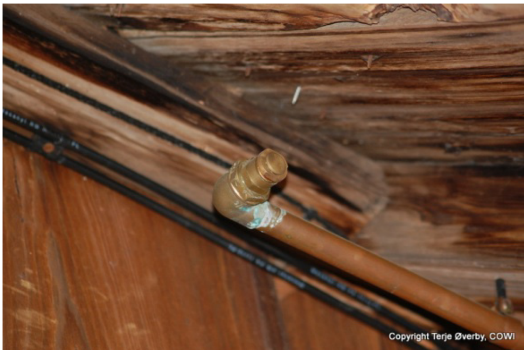
Figur 4: Montering av PVDL langs vegg (Foto: Terje Øverby, COWI, 2011).
