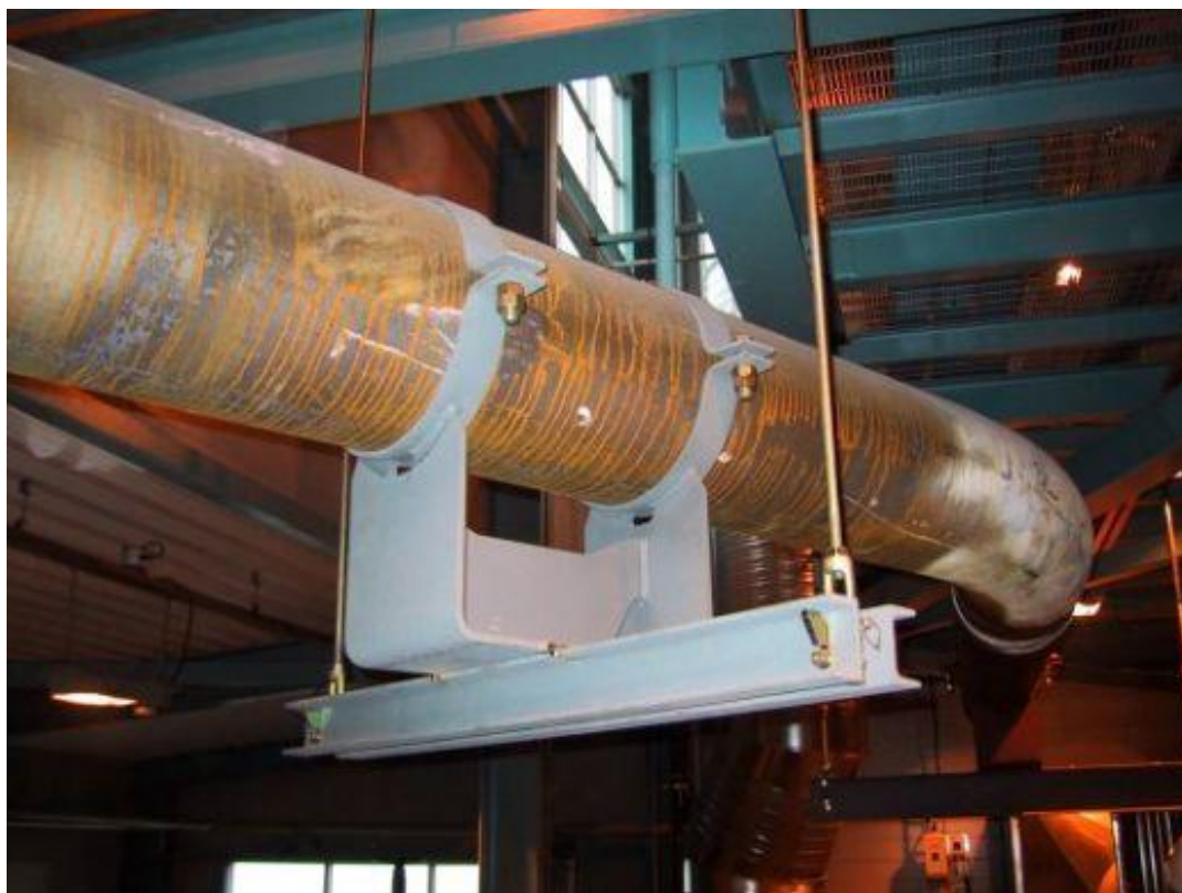
Figur 36 - Her er røret festet med klemmer som holder det stabilt [20]
