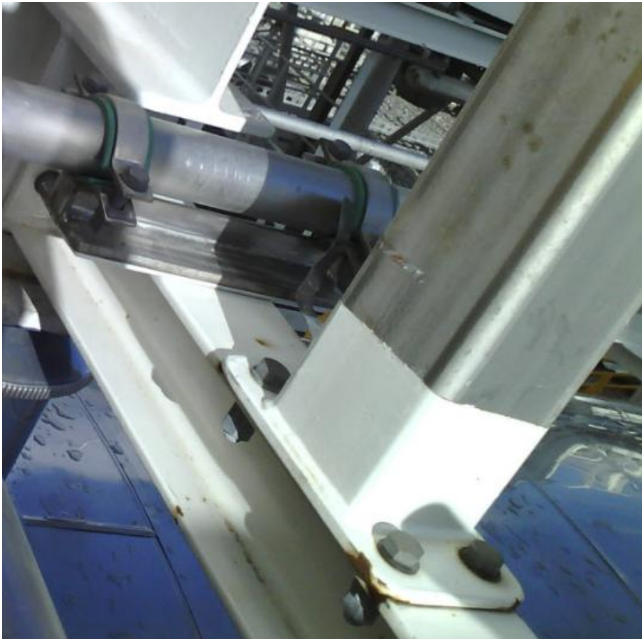
Figur 38 - Feste av plate til supportprofil vha. bolter [21]
