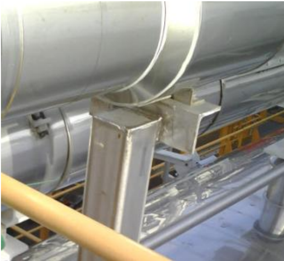
Figur 37 - En annen form for oppstøtting av røret som hindrer det i å rulle av [21]
