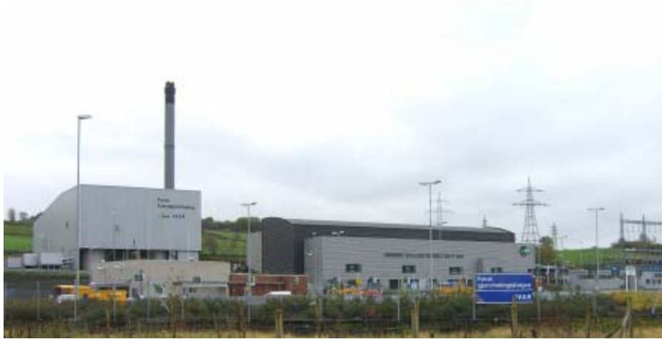
Figur 11.1 Forbrenningsanlegget på Forus
