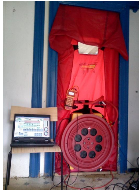
Figur 12: Ventilatordør i Årvik gata
