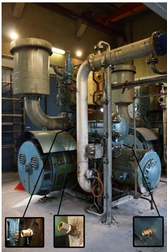
Figur 8 - Plassering av dykkerør etter trinn en, etter mellomkjøler og etter trinn to på en Ingersoll Rand XLE
