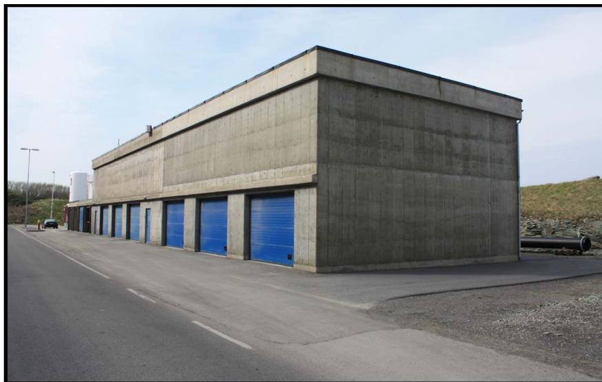
Figur 3-8 viser kompressorstasjon 3. Bilde tatt fra sørøst. (Bilde: Aasen, B.A.E.)
