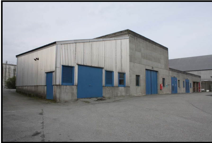
Figur 3-5 viser Kompressorstasjon 2. Bilde tatt fra sørøst. (Bilde: Aasen, B.A.E.)
