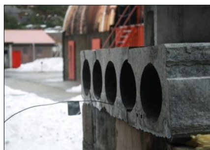
B: Vertikale sprekker i kanaler
