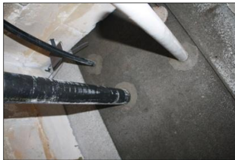
Før test: Fra underside på dekket tatt inne i riggen.
