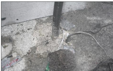
C: Plastrør oppå dekket etter test
