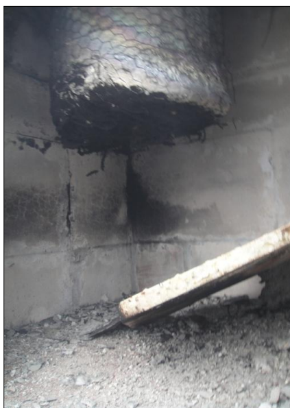
Figur 5-8, Intakt isolering etter test - HD2
