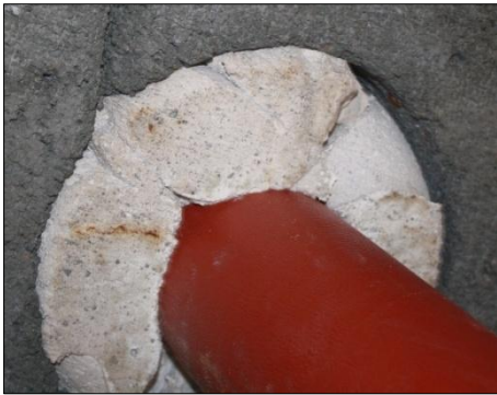
Før test: Gjennomføringen fra undersiden
