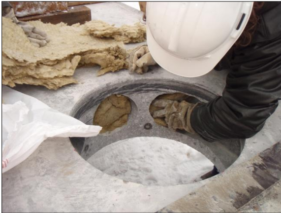
Figur 4-12, Rockwool i kanaler som forsikling
