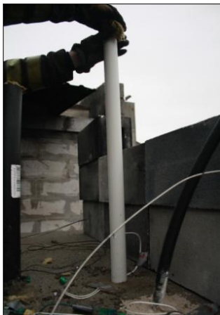
Før test: Rør tettes med Rockwool
