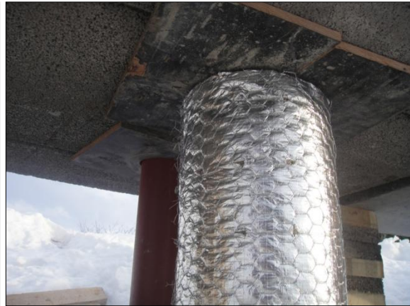
Figur 4-13, Forsikling på undersiden
