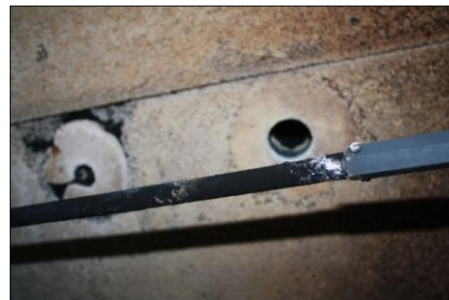
B: Hull etter plastrør er smeltet bort.
