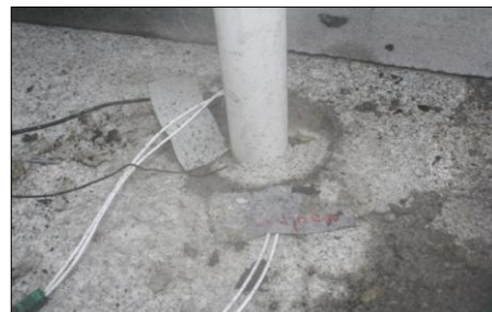
D: Avløpsrør 50 mm oppå dekket etter test
