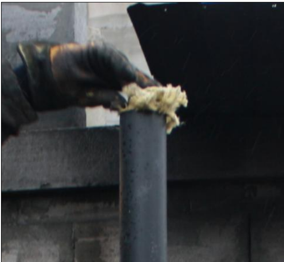
Figur 4-14, Tetting i toppen av rør
