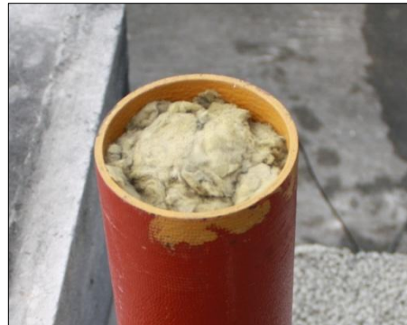
Før test: Soilrøret ble tett med Rockwool også i toppen
