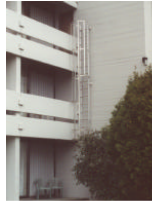
Bilde 6: Rømningsvei fra konferanserom 3. etasje.
