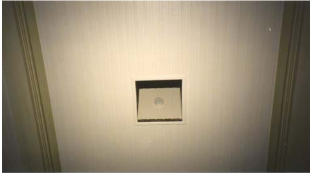
Bilde: Ventilasjonssluge i taket i storsal
