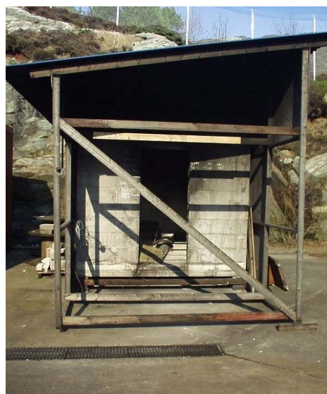
Fig. 3.2 Bilde av ISO-rommet sett forfra.
