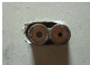
Fig. 3.4 Bilde av varmekraftmålerne, Total varmekraft t.v og Strålefluks t.h.
