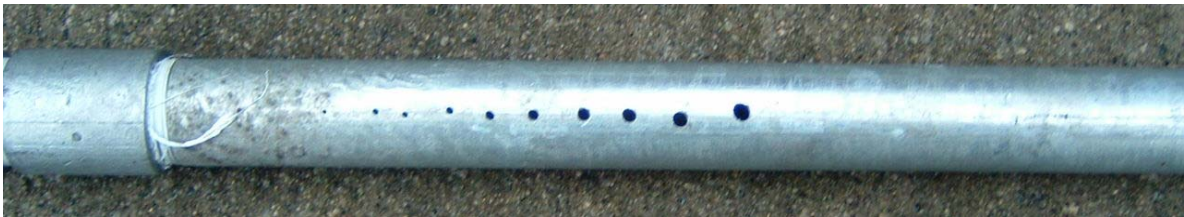
Bilde 3: 33,7 mm rustfritt rør med hull
