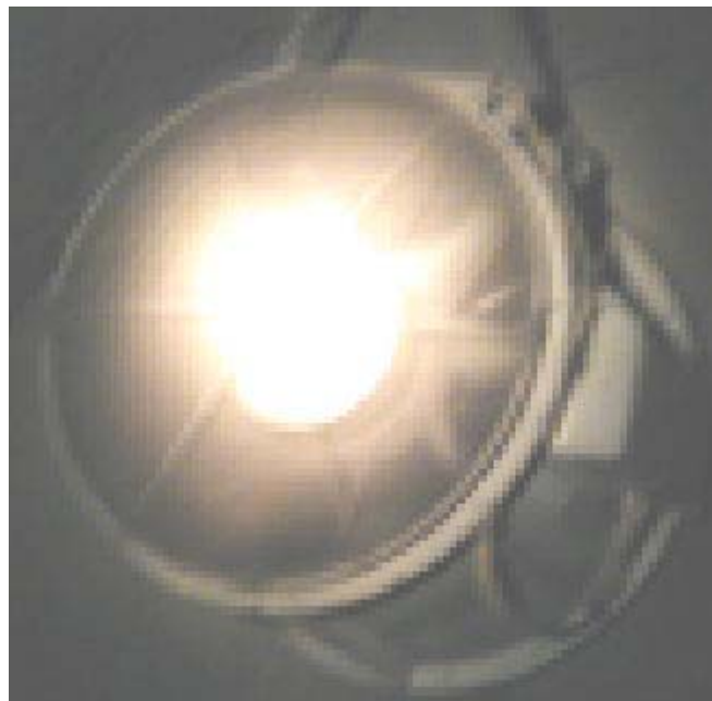
Bild 9. Frånluftsfläkt (till frånluftsschakt)
