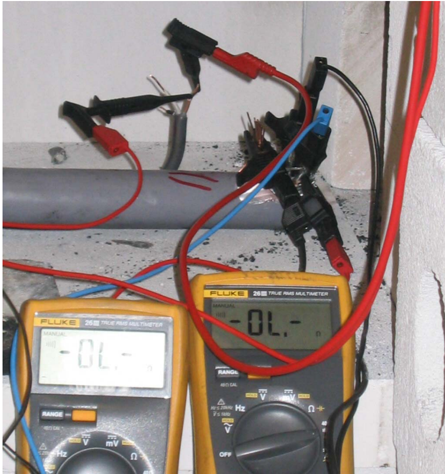
Vedlegg 14: Kobling av multimeter til ledere for måling av kortslutning.
