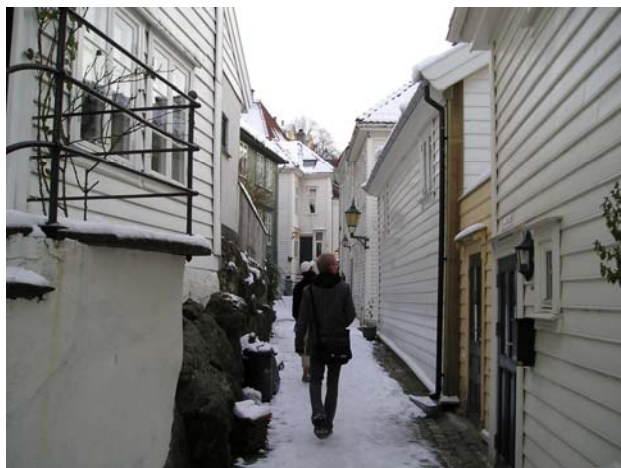
Figur 6: Viser noen av problemene: 1) Her kommer ikke brannvesenet seg fram, 2) Høydeforskjellen mellom husene, 3) trefasade og mange vinduer, 4) I tillegg til stråling kan en brann spres ved konveksjon (dvs. at flammer og varme gasser kommer i kontakt med husene som ligger på oppsiden).
