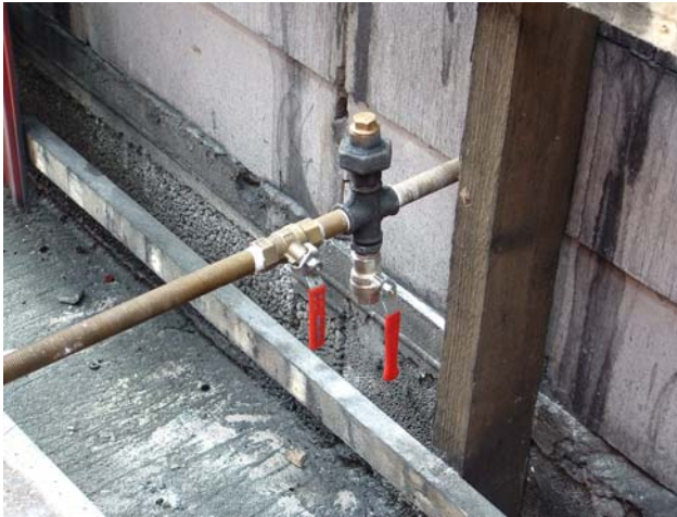
Figur 4.23 Ventiler for tapping av brensel
