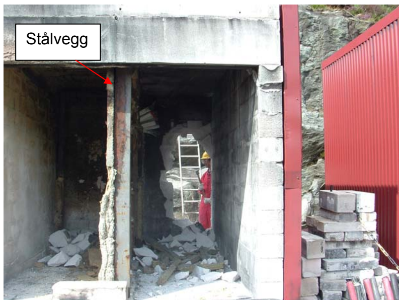
Figur 4.17 Modifisering av fullskala testtrigg
