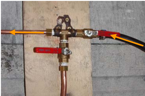
Figur 4.13 Ventilenes normalstilling
