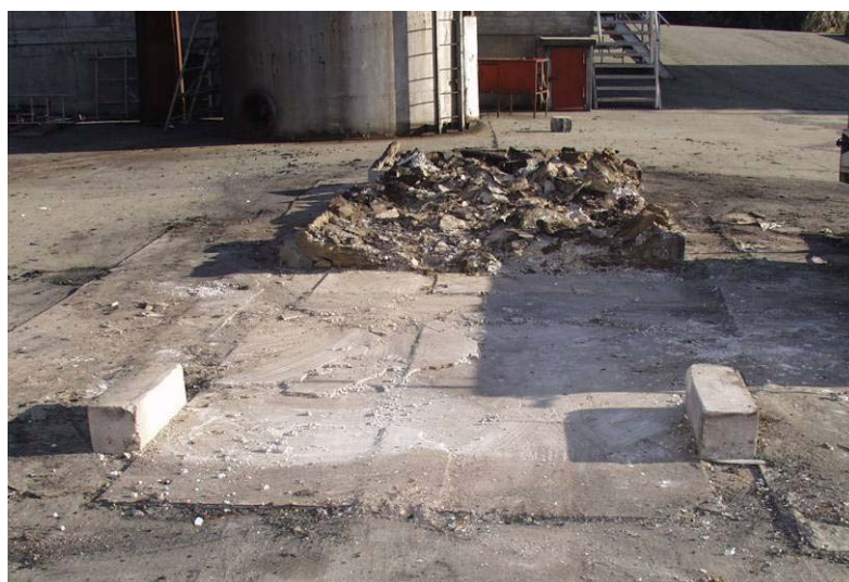
Figur 13 Omtrent halvveis i utgravingsarbeidet
