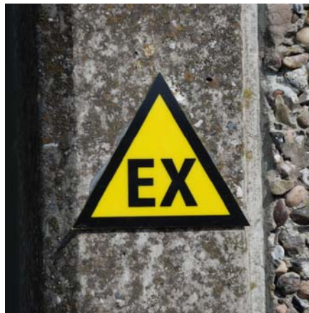
Bilde 7: Skilt som sier at området kan danne eksplosiv atmosfære [27, 19]
