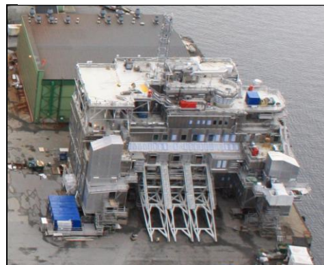
Figur 22 GjØa boligmodul under bygging pØ Leirvik MT. Foto E.O.Hukset.
