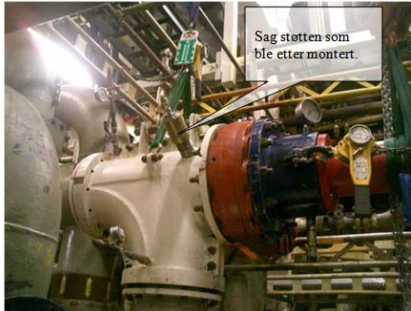
Figur 4 Bilde av "hot-tap" utstyret montert på røret.
