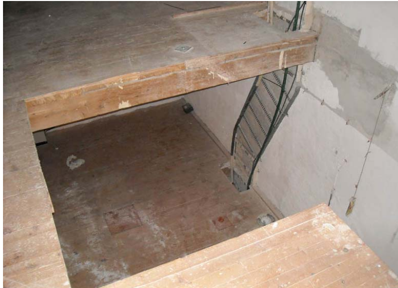
BILDE 1.2 – INNVENDIG ETASJESKILLER OG GJENNOMFØRINGER
