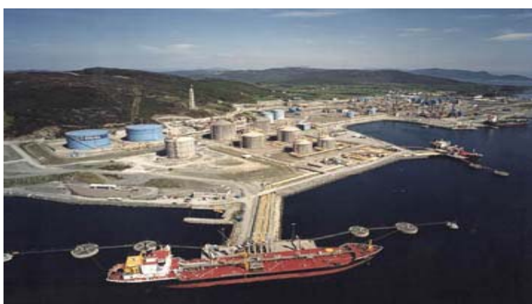
Foto 1: Statoils gassprosesseringsanlegg på Kårstø
