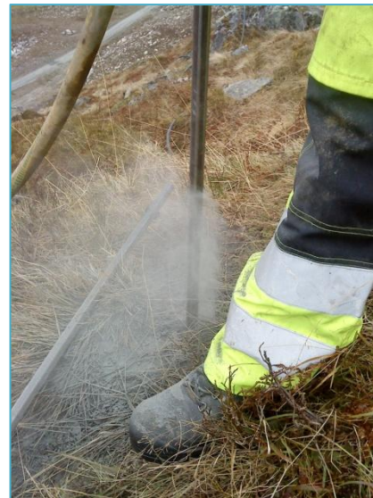
Bilete 20: Boring gjennom blokker
