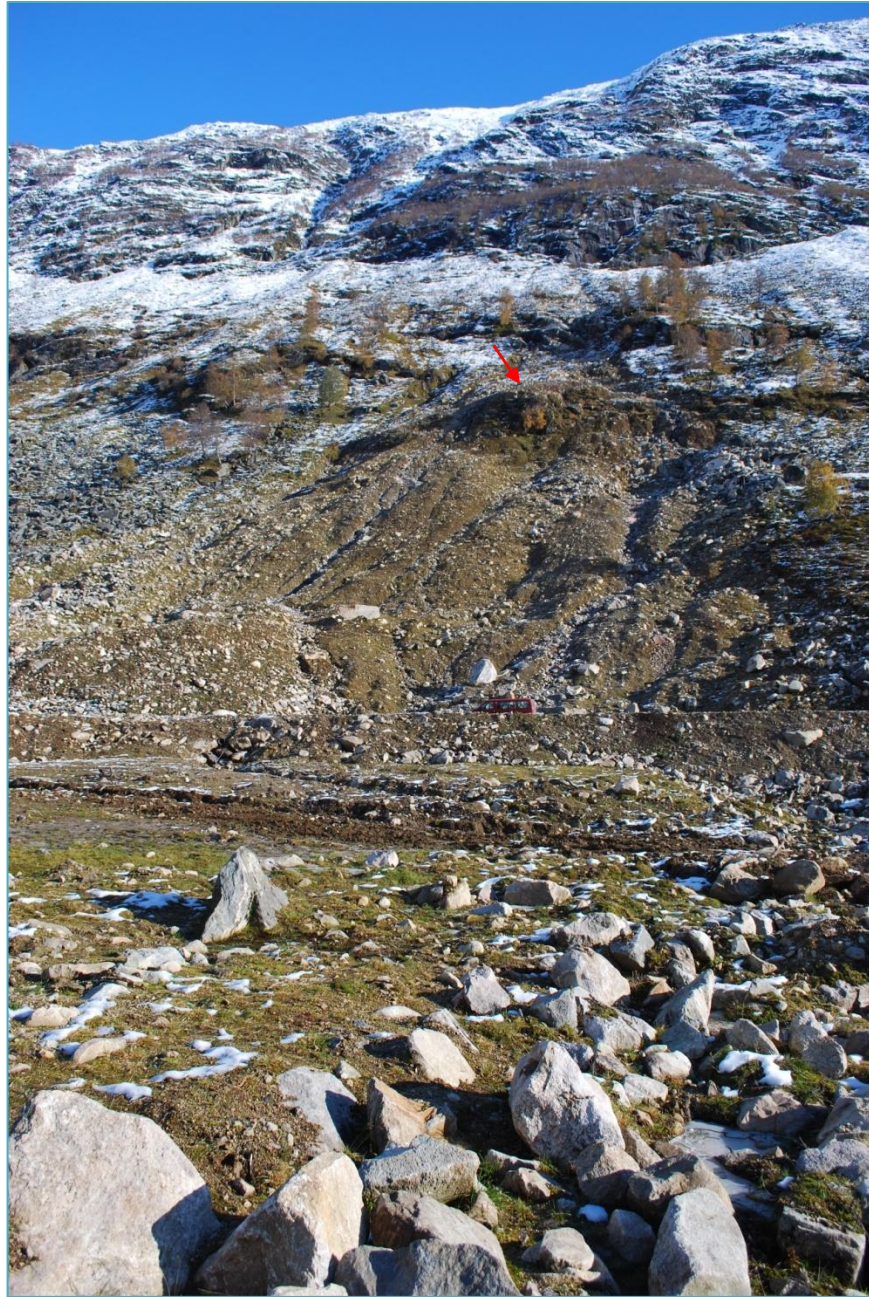
Bilete 19: 2007-skredet sett frå sørkanten av skredet nedom vegen. I front kan ein sjå delar av dei blokkrike leveane som omringar store delar av skredet. Legg også merke til dei ulike erosjonsspora i skredet. Den raude pila syner forhøgginga i terrenget der skredet byrja å utvide seg. Biletet er teke hausten 2009.
