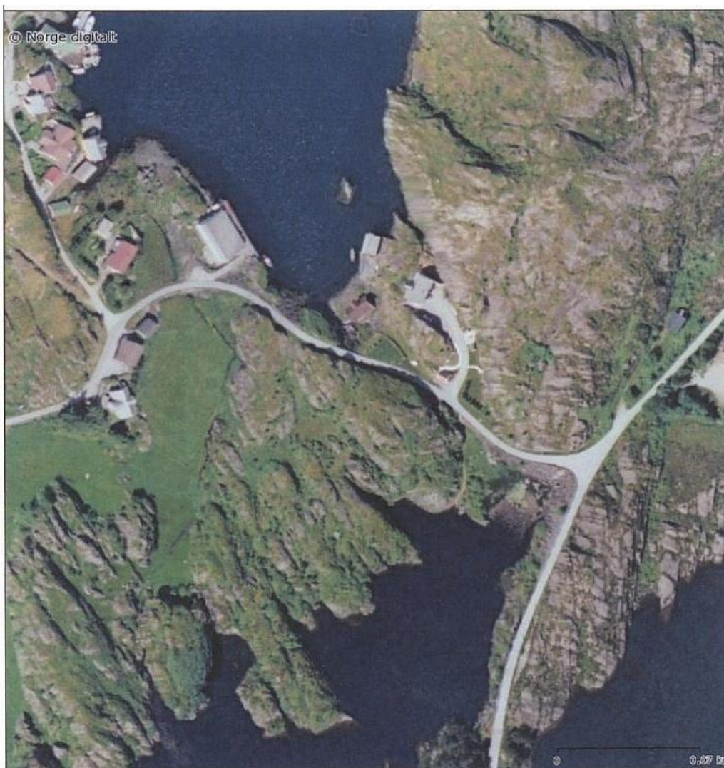
Fig. 28. Flyfoto av det aktuelle planområdet. Utbyggingsområdet omfatter knauseområdet sør for vegen og nord for Olavatnet. Byggegrensene er trukket inn fra sjø (i nord) og fra vann (øst og sør) og berører heller ikke dyrka mark i vest. Grendehuset kan så vidt skimtes i høyre bildekant.
